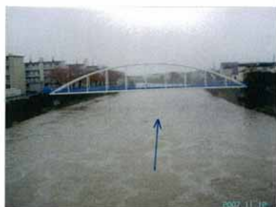
(5) 駒込川 (桜川団地付近)
