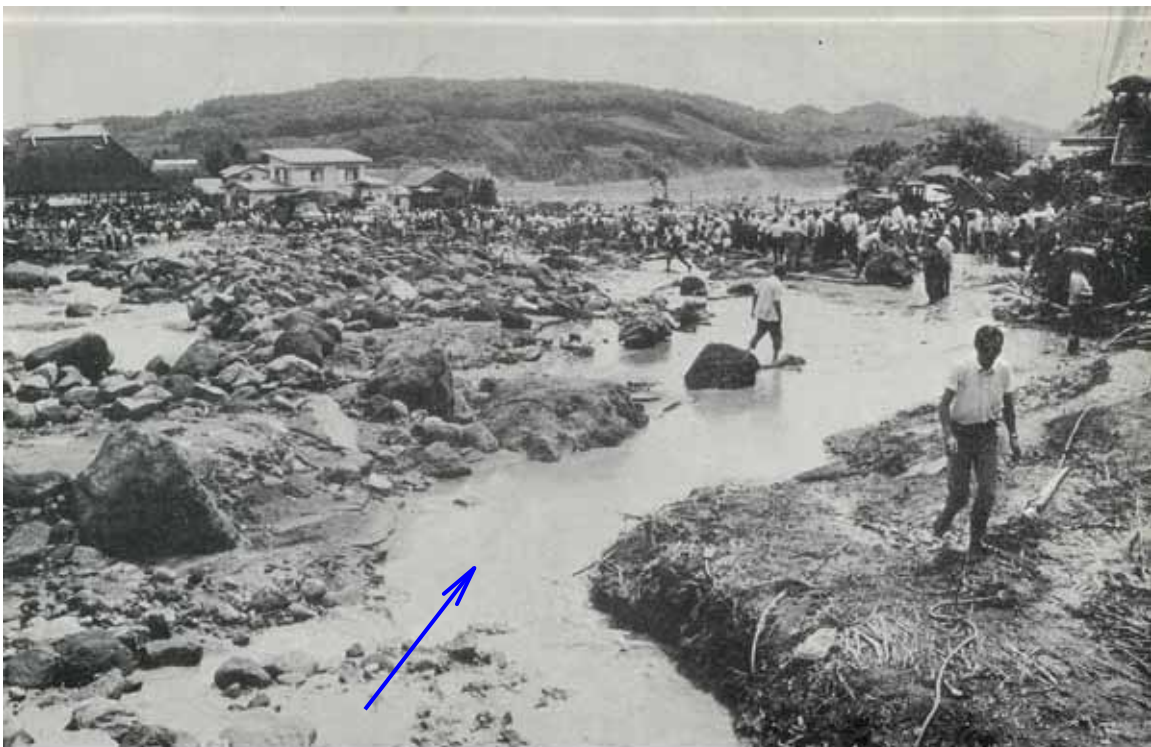
写真.5-6 河原と化した百沢部落 - 下流方向 -
