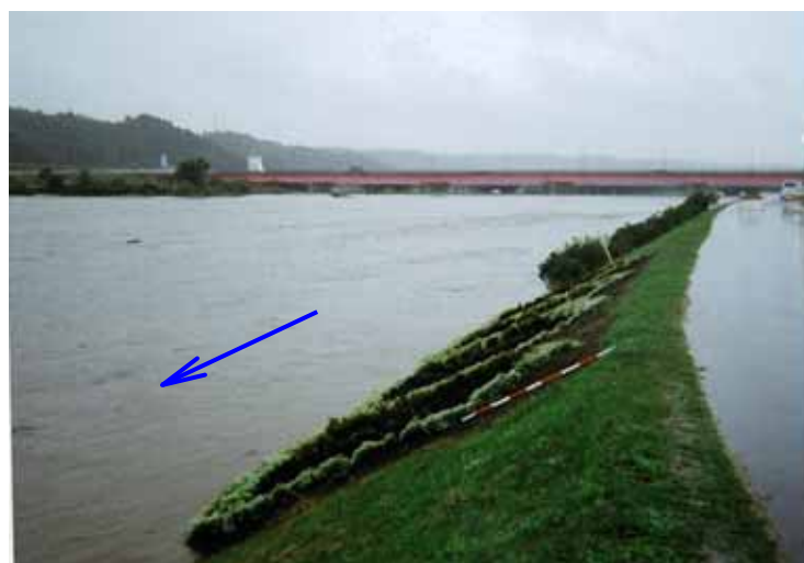
写真. 5-9 奥入瀬川下流（幸運橋地点）
